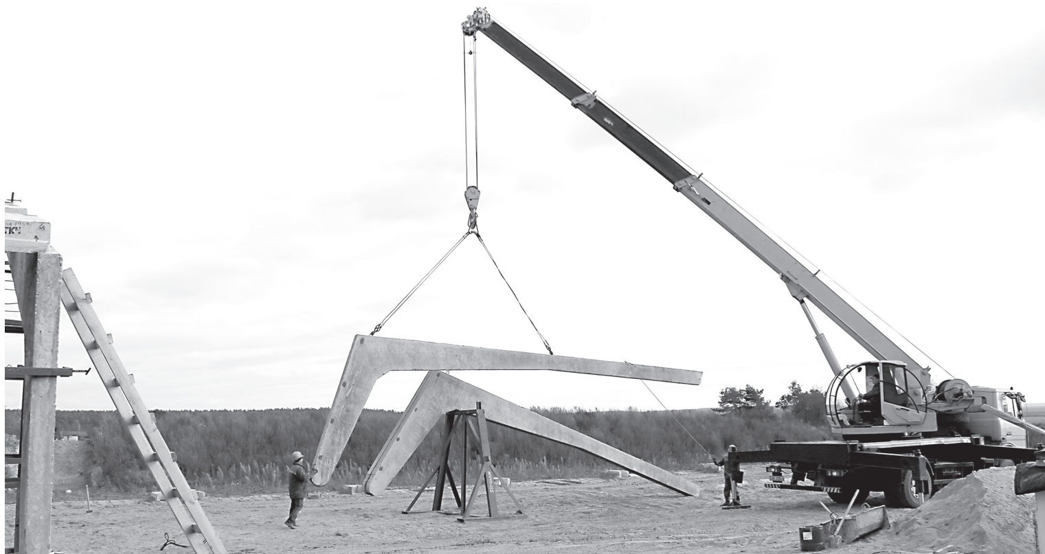
Строители МПМК-155 начали монтаж коровника в ОАО «Черлёна».
