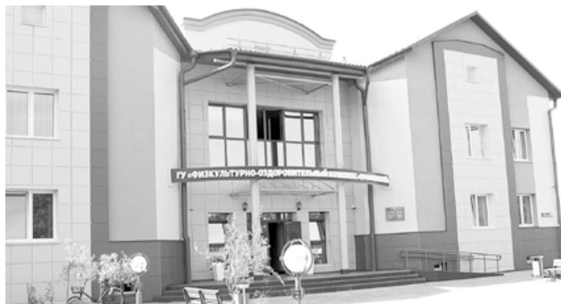
Так теперь выглядит обновлённое здание бассейна.
