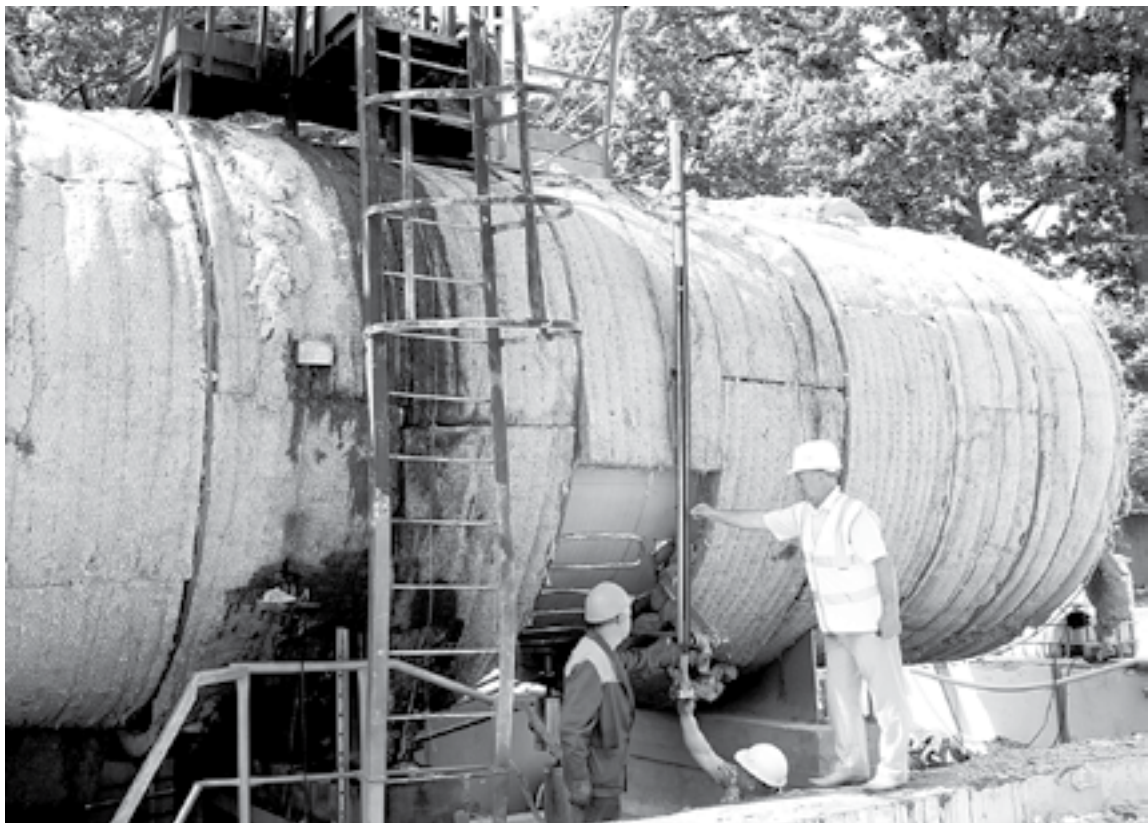
С. ОСОСОВ контролирует ход работ по ликвидации последствий инцидента.
