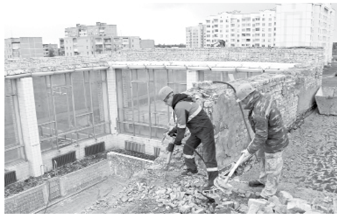
Ведутся демонтажные работы стен бассейна.
