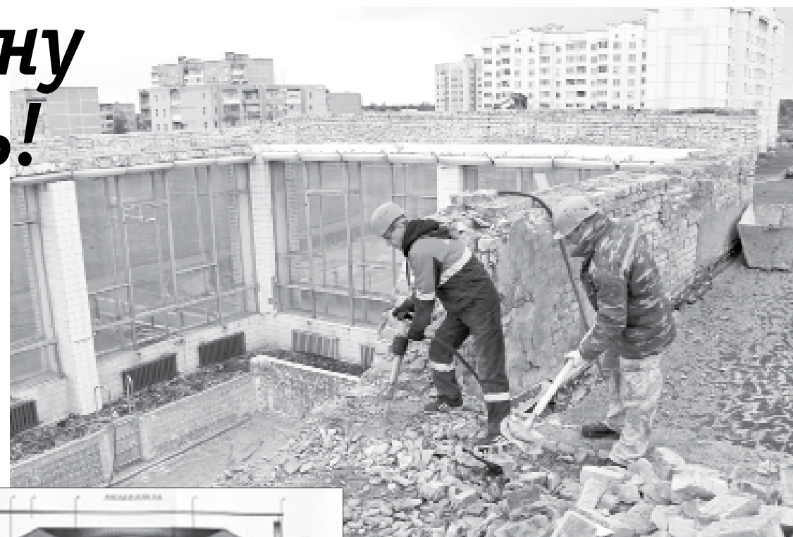
Ведутся демонтажные работы. Фото В.ДЕРНЕЙКО
