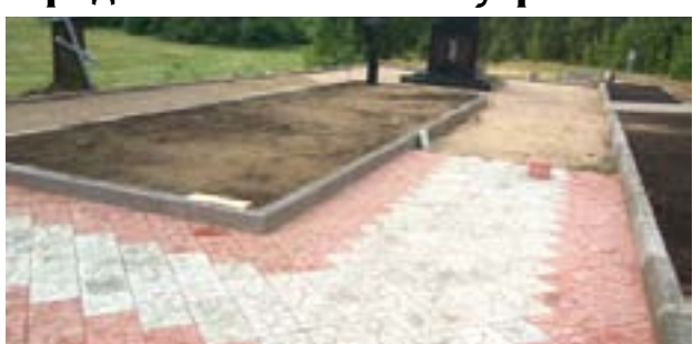
Укладка плиточного покрытия РУП ЖКХ.
