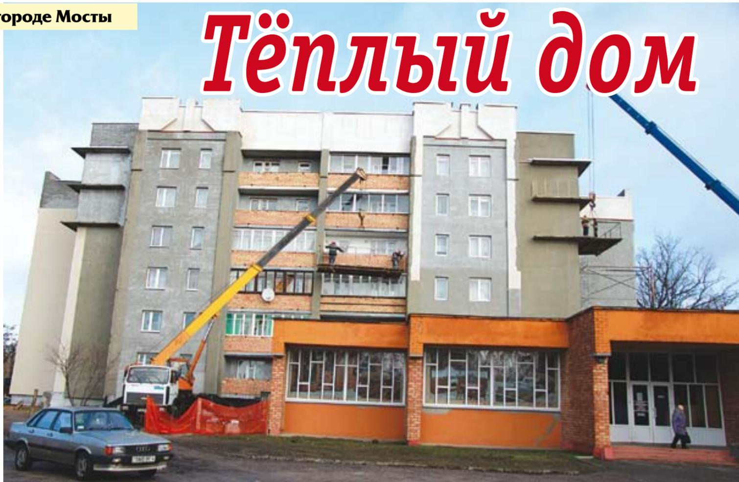
Утеплены технические помещения пятого, шестого этажа. Произведён ремонт лестничных клеток, на них были заменены дверные и оконные блоки, стены облицованы керамической плиткой. Произведено устройство декоративных экранов на балконах и в лоджиях.
